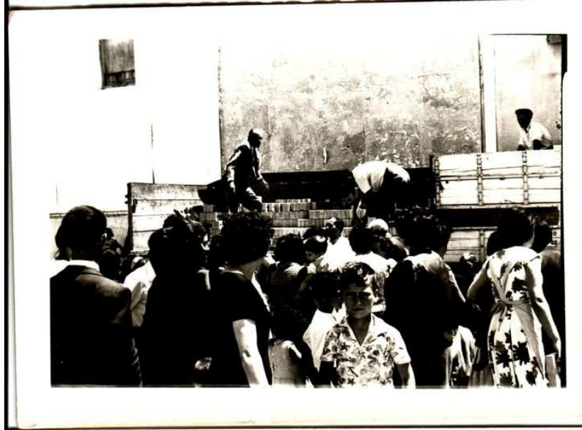
Comprando ladrillos para construir la iglesia del Llano
