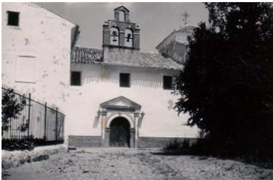
Estado actual de la entrada al Santuario
