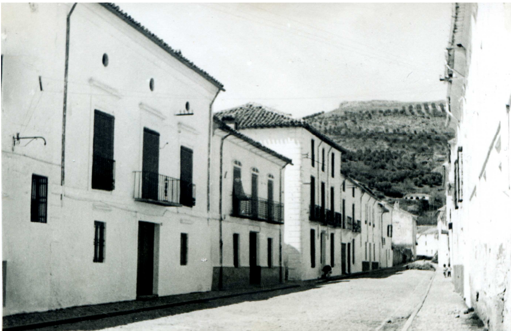
Calle Carrera. En el tercer edificio a la izquierda se encontraba el Cuartel de la Guardia Civil
