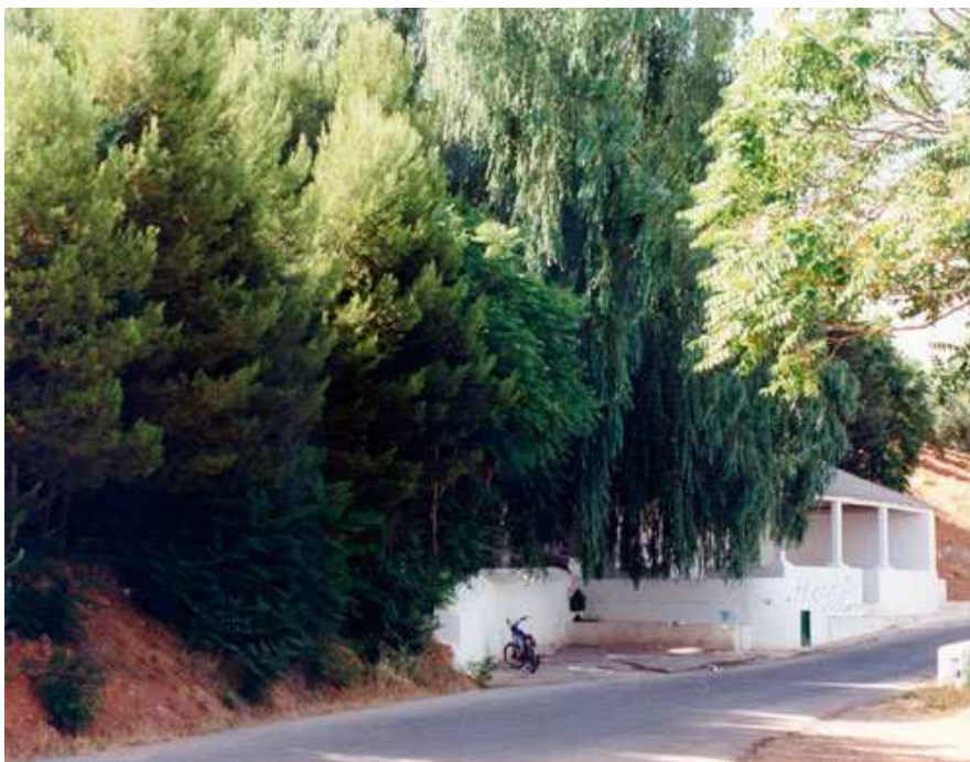
Fuente de la Teja antes de la restauración.
