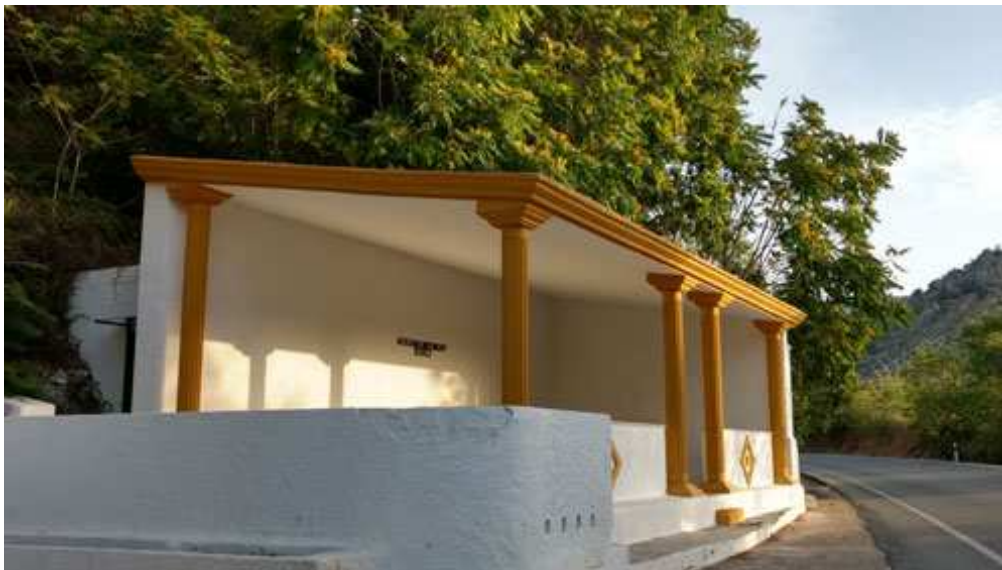
Lavadero de la Fuente de la Teja actualmente.
