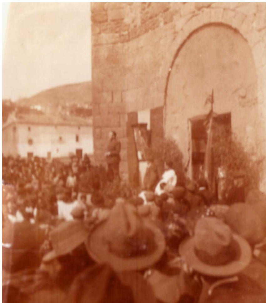
1925. En la fotografía se aprecia la puerta de entrada a San Marcos construida sobre un arco cegado.
