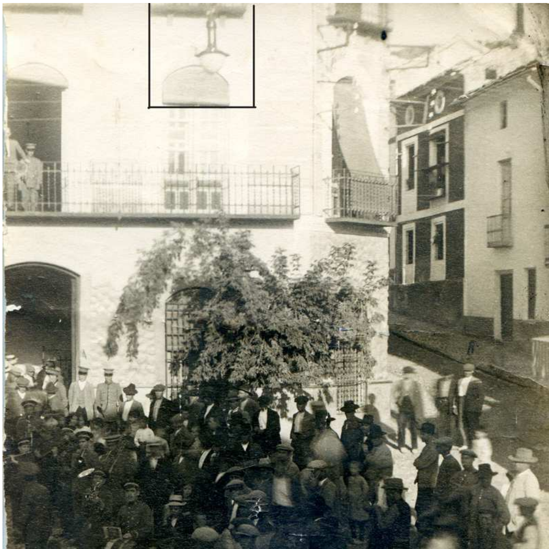
En recuadro la farola que iluminaba el Ayuntamiento.
