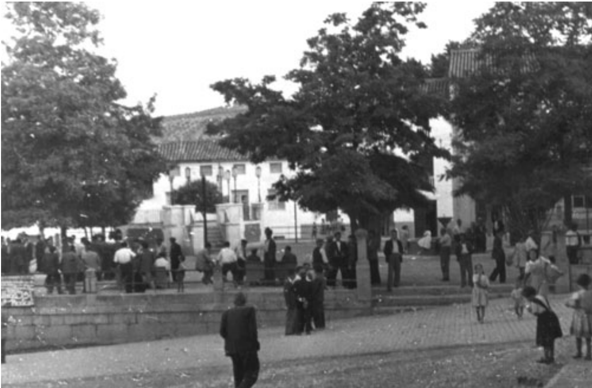
Plaza construida sobre el solar del Convento.
